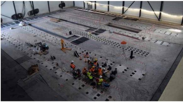
Terrasol est intervenue récemment pour le compte du Groupe Renault dans le cadre du projet de construction d'un simulateur de conduite pour le développement des futurs systèmes d'aide à la conduite et des véhicules autonomes au Technocentre de Guyancourt (78). La mission de Terrasol : qualifier et valider la réponse dynamique et vibratoire de la fondation du simulateur vis-à-vis des critères de performance imposés par le fabricant.
