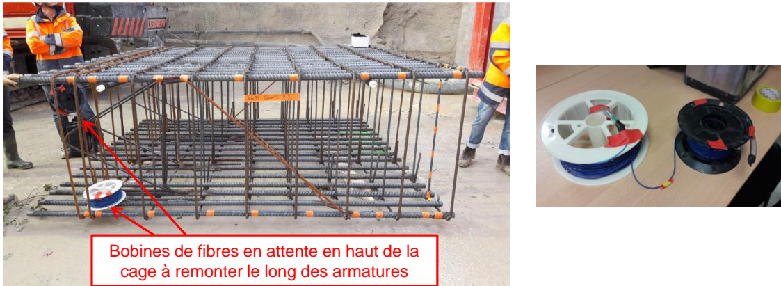
Figure 8 : Cheminement de la fibre optique à l'aide de deux bobines
