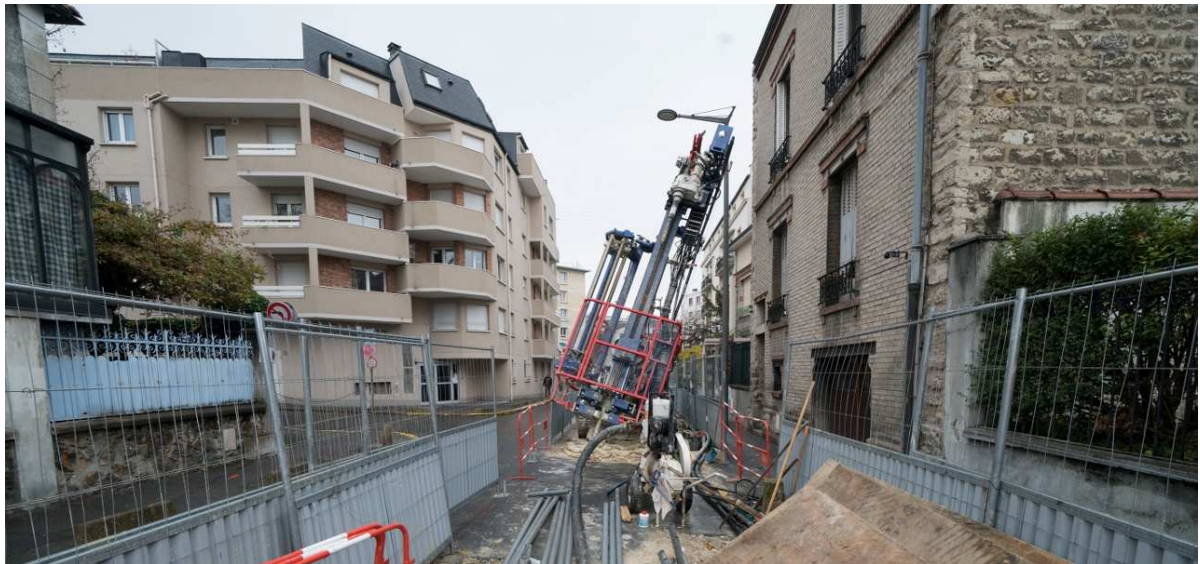
Figure 11 : Exemple d'emprise pour forage : Zone 11, inclinaison du mât de la foreuse jusqu'à 45°
