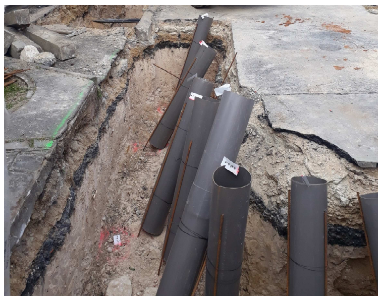
Figure 9. Fouille de reconnaissance et réservations en tube PVC pour réalisation de forages
