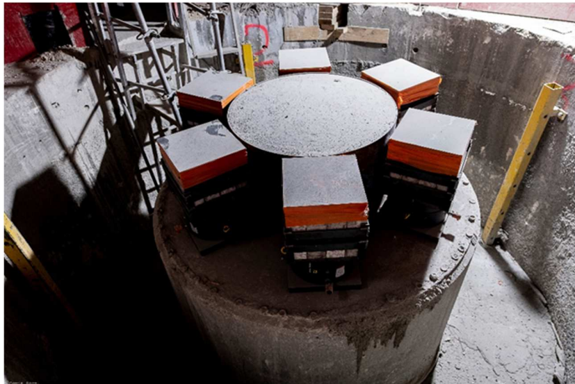
Figure 14 - Couronne de vérins et camarteau en tête de piliers
