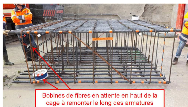
Figure 5 : Illustration d'une cage équipée de fibre optique
