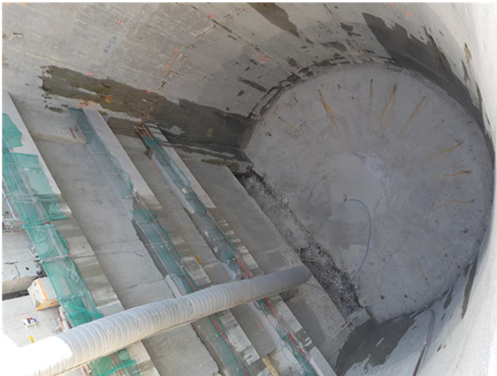
Figure 19. Vue du lobe ouest à la fin du terrassement et avant mise en place du radier
