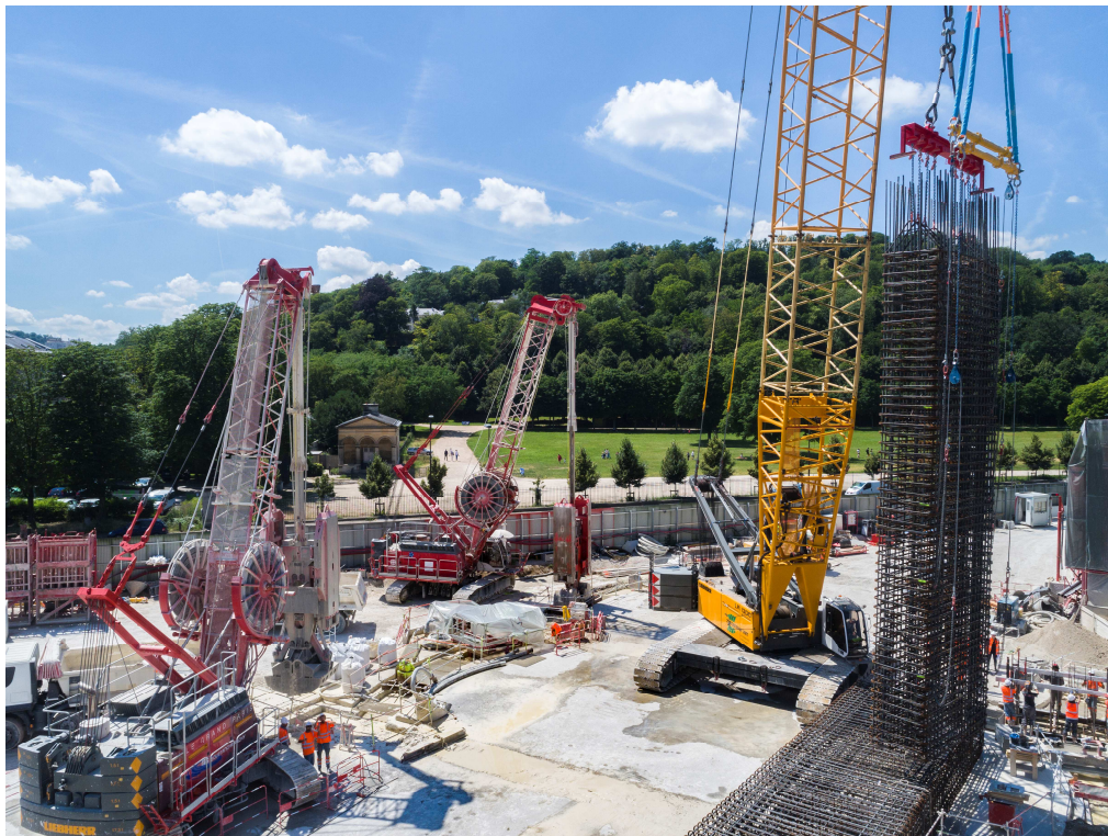
Figure 17. Atelier de paroi moulée et levage cage linteau
