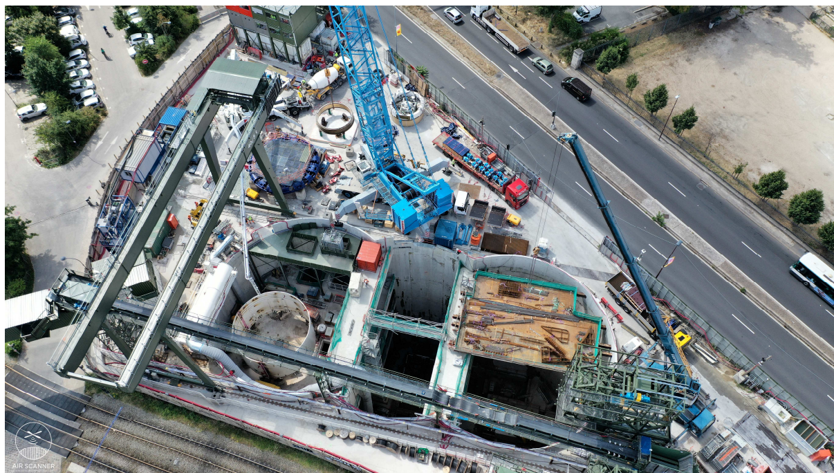
Figure 20. Vue aérienne de l'ouvrage – assemblage de la roue de coupe et montage du bouclier du tunnelier
