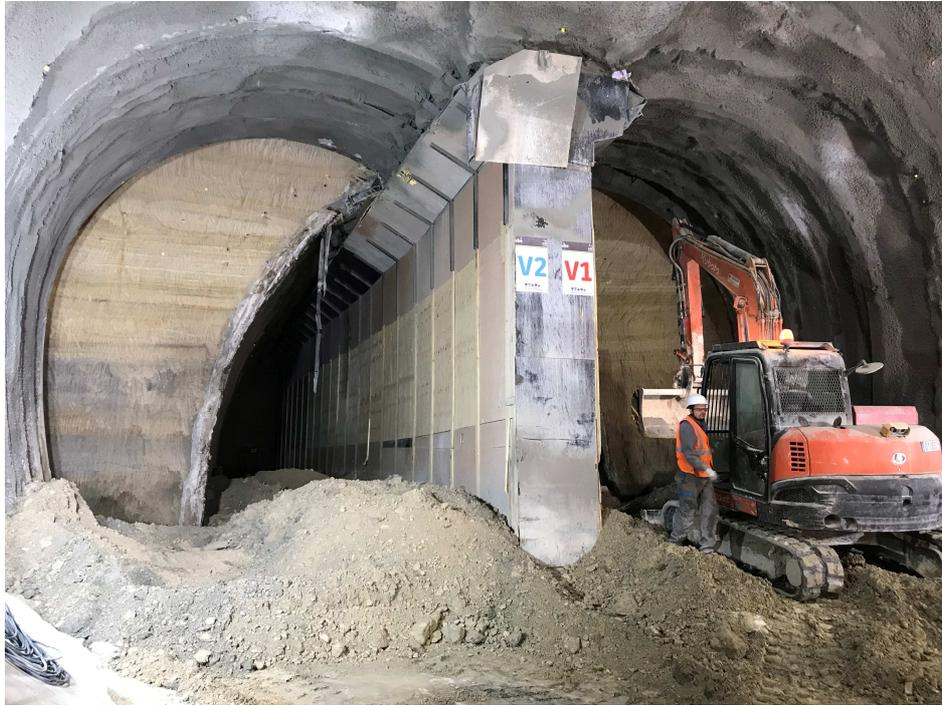
**Figure 9. Excavations des galeries oreilles – Chambre C3 Entonnement Est**
