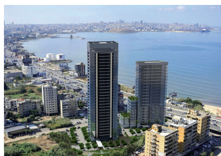
Crystal Towers (Beyrouth, Liban) Fondations conçues avec Groupie+ et Tasplaq
