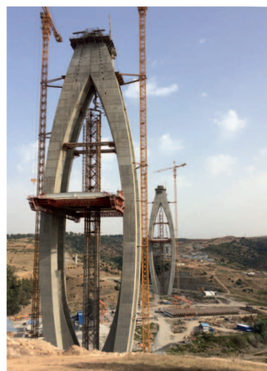
Viaduc du Bouregreg
