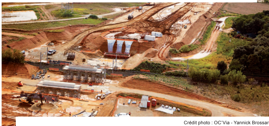
Crédit photo : OC'Via - Yannick Brossard
