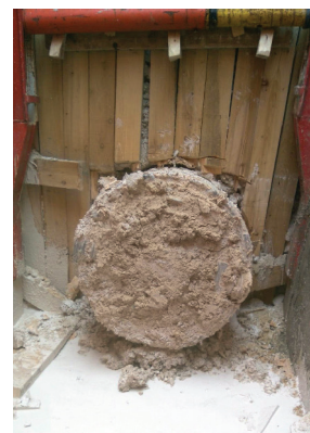
Sortie du microtunnelier, passage dans de la craie à silex – Crédit photo : Entreprise Valentin
