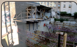
Exemples de désordres affectant des ouvrages courants
